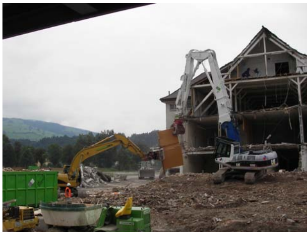
Vorsortierung beim Rückbau
