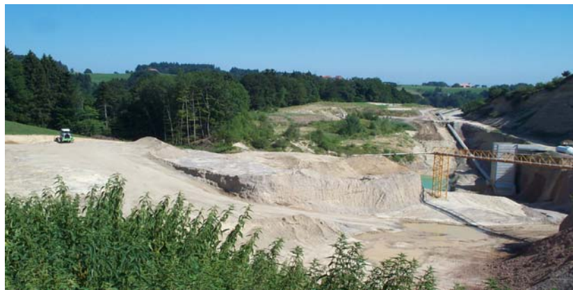
Abbau, Aufgabestelle, prov. Bachüberführung
