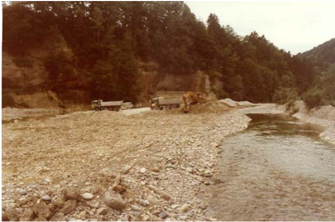
Flussabbau am Neckar
