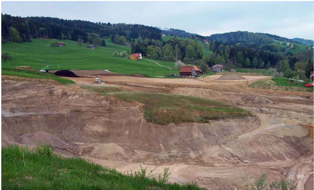
Umfangreiche Geländeanpassung als Immissionsschutz, Bachbau
