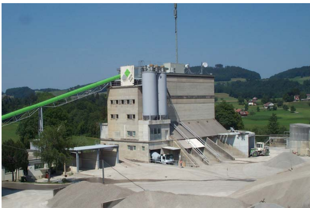
Kies- und Betonwerk Bütschwil 2006
