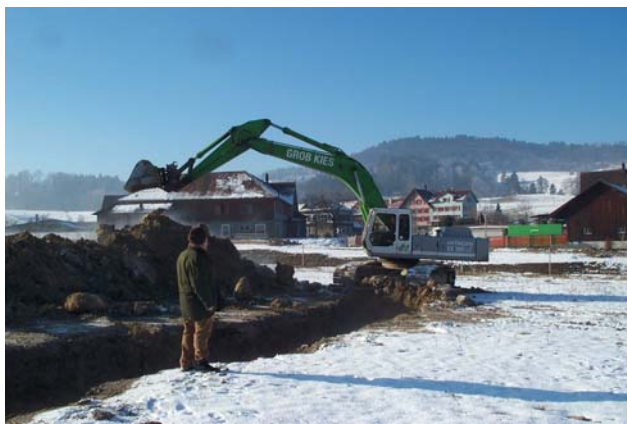
Spatenstich mit Reto Zingg
